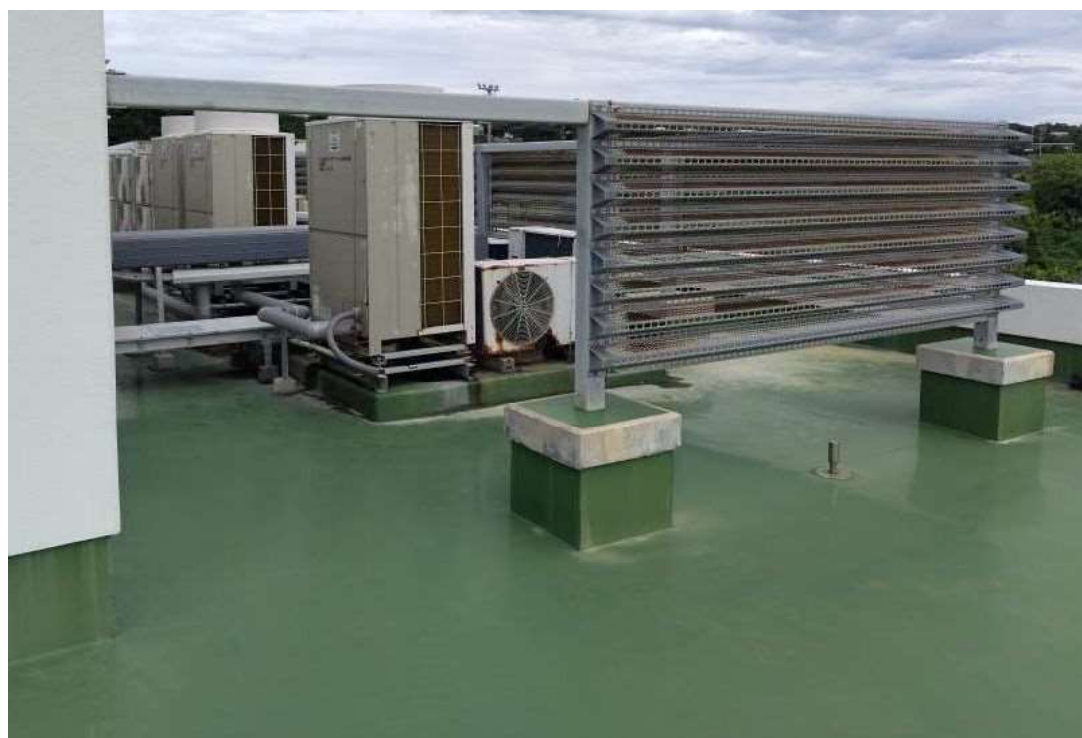
屋上図②矢印方向 からの撮影
