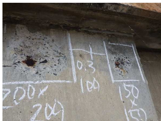
【南洲橋(上流側)：修繕前】
