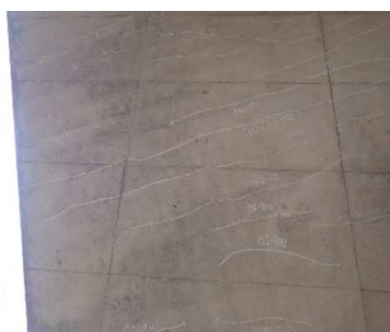
【健全性Ⅱ：大城橋】
