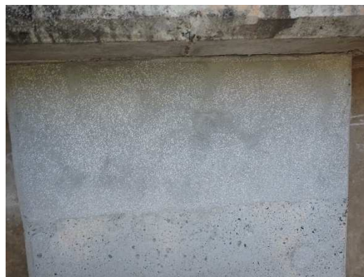
【南洲橋(上流側)：修繕後】
