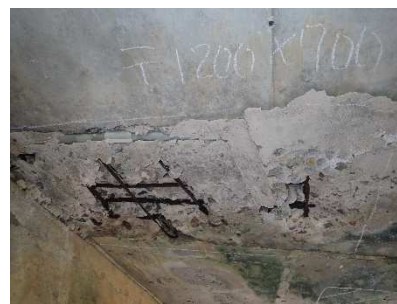
【健全性Ⅱ：兼久橋】
