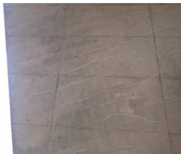
【健全性 II : 大城橋】
