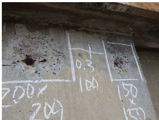
【南洲橋(上流側) : 修繕前】
