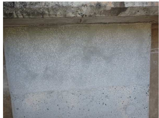
【南洲橋(上流側) : 修繕後】
