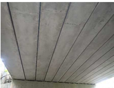
【健全性 I : 昭和橋】
