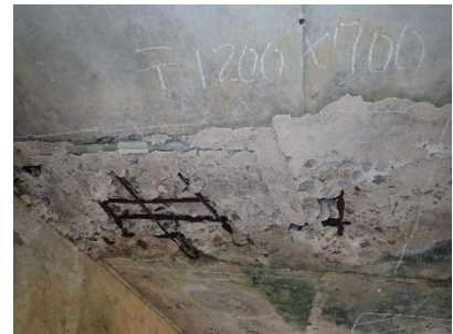
【健全性 II : 兼久橋】
