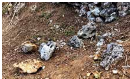
崩落した石材
