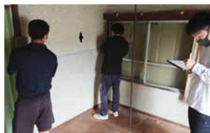
空き家実測調査
