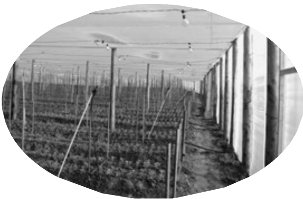
整備が進む木柱平張り施設
