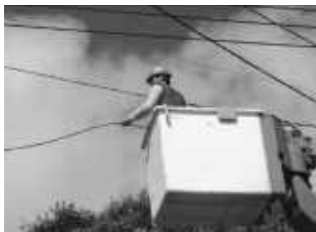
「SSTVケーブルの補修作業」
