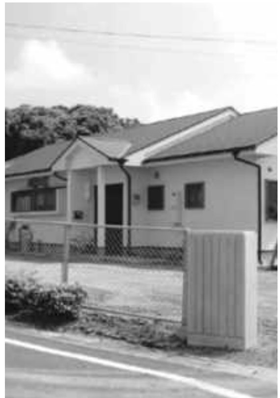
「町営住宅 永嶺団地」 -H19.3完成-
