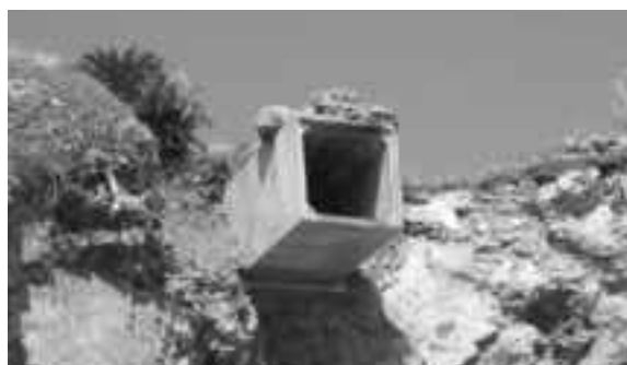
「周囲の土砂が崩落した排水溝」
