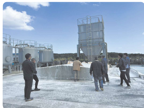
▲硬度低減化施設の現場確認
