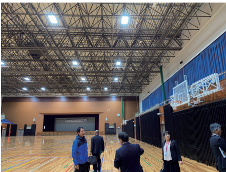
指宿市：体育館冷暖房施設
