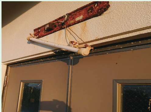
▶ 老朽化が進む施設
