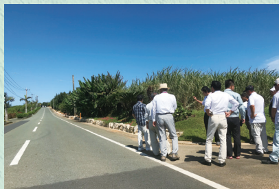
県道知名沖永良部空港線石積工事
