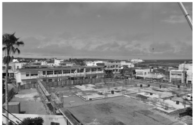
1階の躯体工事 土間のコンクリート打設が終了し、外部足場組立中で今後1階配筋、型枠工事と入って行きます。
