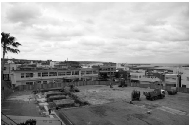
1階の躯体工事 土間のコンクリート打設が終了し、外部足場組立中で今後1階配筋、型枠工事と入って行きます。
