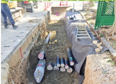
電線共同溝整備事業
