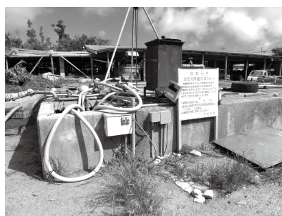
老朽化が進む有機物供給センター
