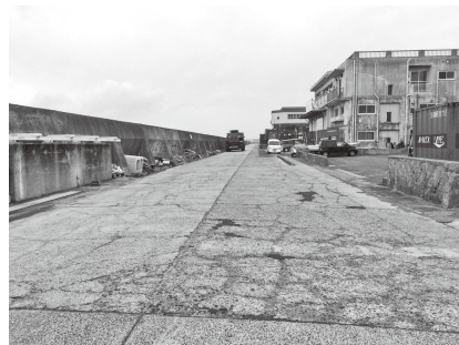
埋立地から和泊港までの臨港道路
