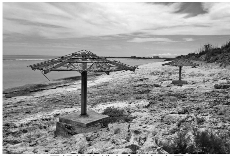
屋根部分が腐食した東屋
