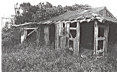
台風に屋根等が飛散し、危険な状態の空き家
