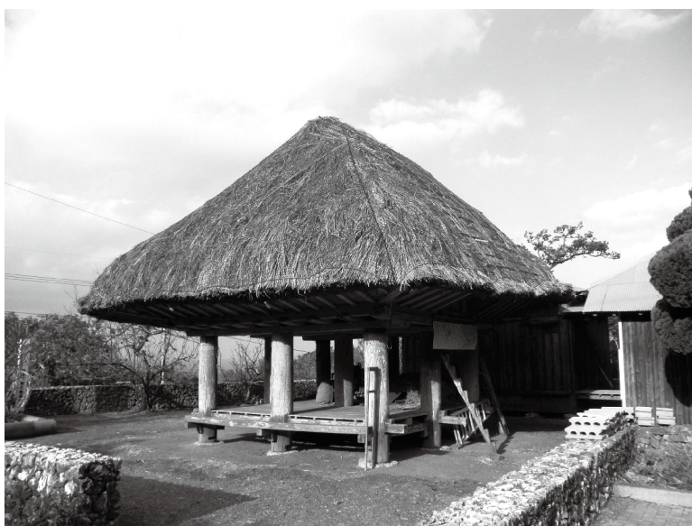
腐食が進み早期補修が望まれる研修センター入口横の高倉
