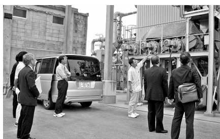
エタノール製造施設
