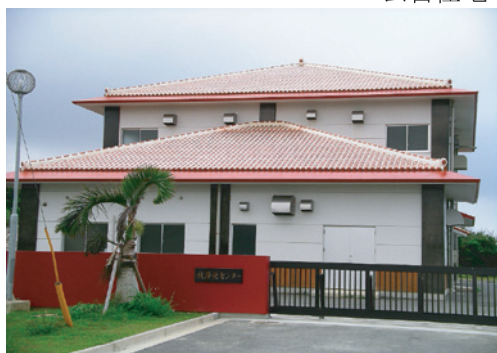
下水道処理施設
