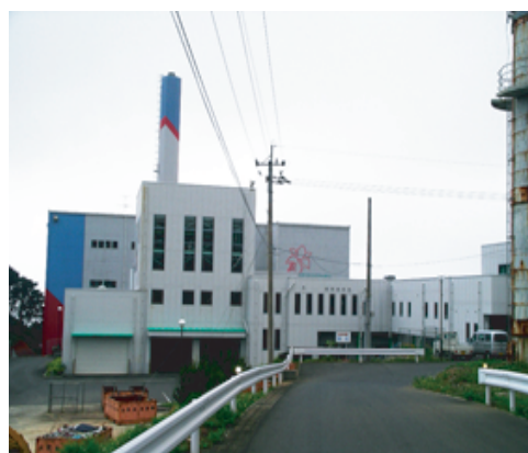
沖永良部クリーンセンター
