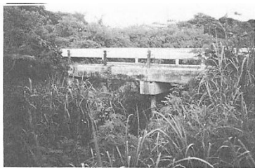
最初に架けられた与名川橋（手々知名、旧とさつ場上） 昭和40年代にコンクリート橋に架け替えられた。
