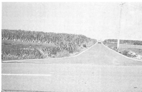
舗装された農道
