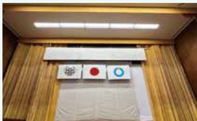
▲体育館舞台のLED照明（更新）
