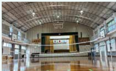
▲体育館のLED照明（更新）
