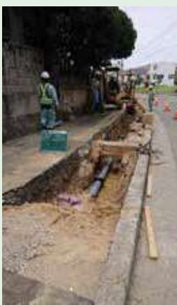
▲無電柱化工事
