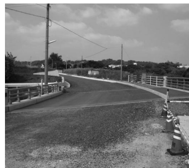
工事中の昭和橋
