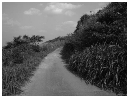
雑草が繁茂する道路
