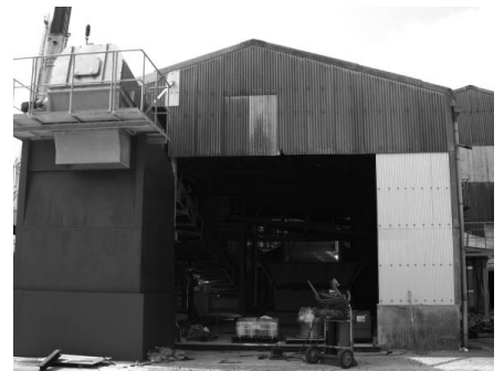
整備される精脱葉施設
